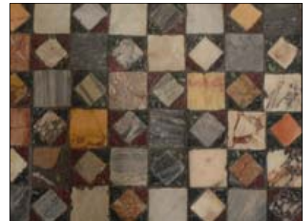
Pavimento della basilica
